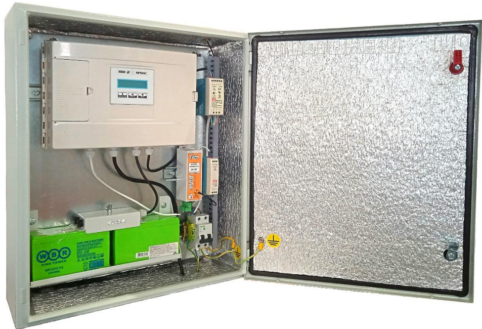
Рисунок 1 – Общий вид шкафа КИП в максимальной комплектации.
